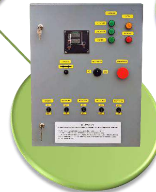
Система дозирования с компьютером
